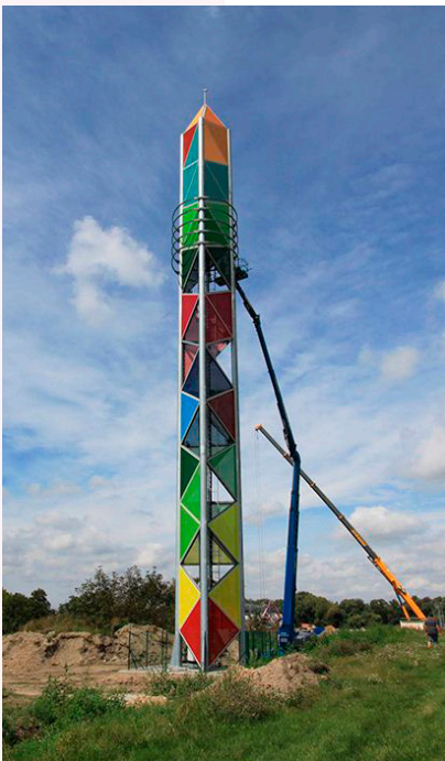
▲ A képen látható tornyok: Színes textillel álcázott torony (30m), kilátóként megépített acélrácsos torony (50m), fatartóként épített monopol torony – ECOPOL (30m) fenyőfának álcázott monopolt torony (30m)
